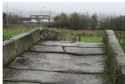
Ponte de Augapesada
